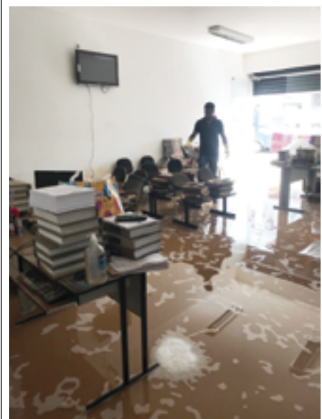
No 2º Distrito da Sede da Comarca de Cachoeiro de Itapemirim (ES), o estrago no cartório foi imensurável por causa das chuvas do verão de 2020
