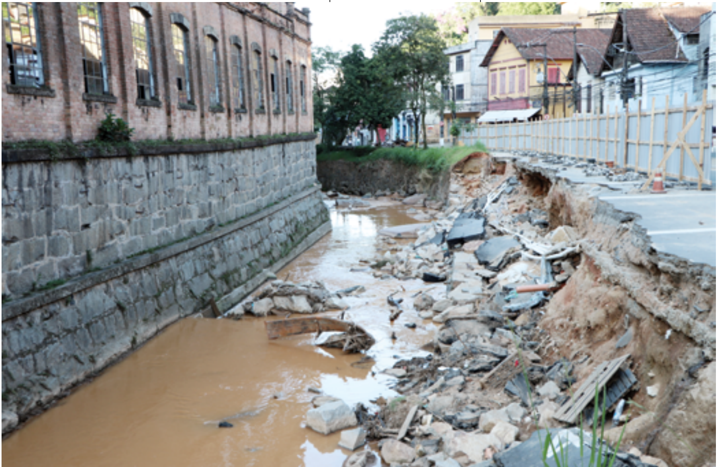
Trecho da rua Washington Luiz, em Petrópolis (RJ), foi completamente destruído por causa da forte chuva que abalou a cidade e deixou centenas de mortos
