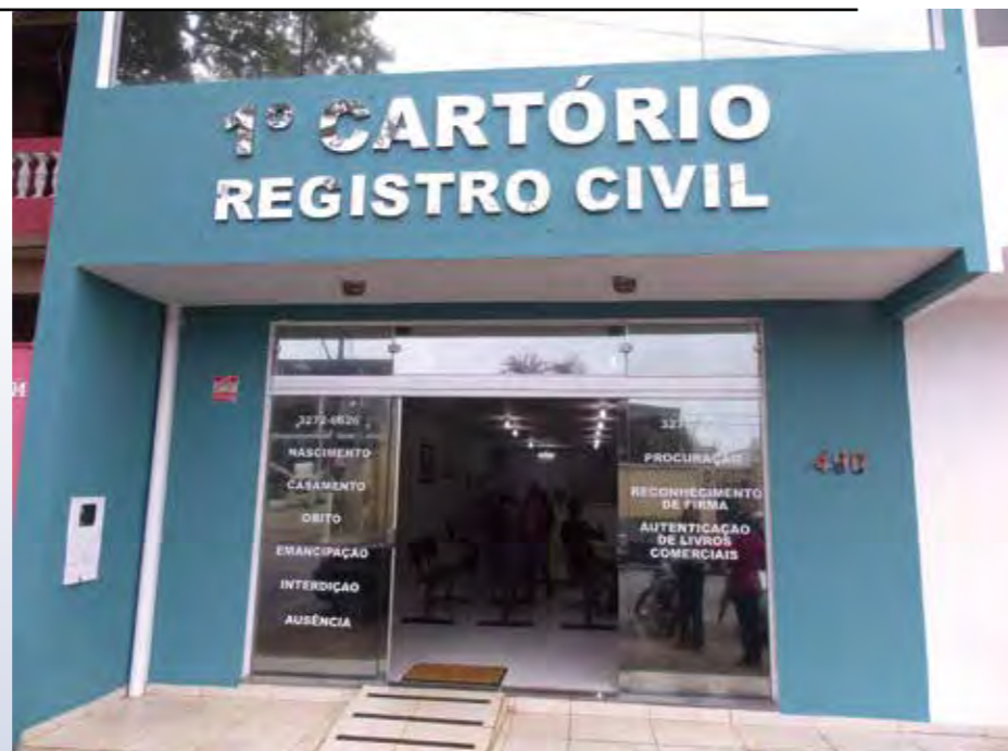
As novas instalações do recém inaugurado Registro Civil do 1º Subdistrito de Itapetininga
