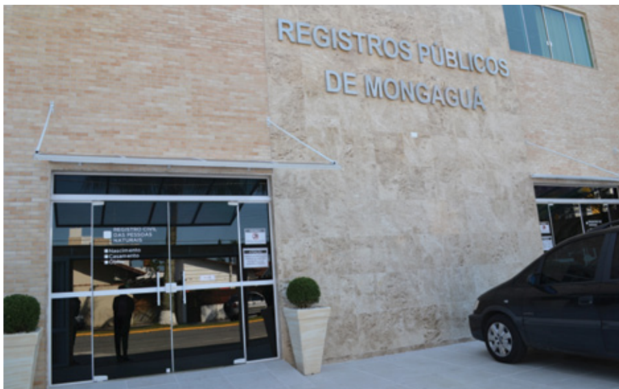
Fachada do Cartório de Mongaguá, que congrega Registro Civil e Registro de Imóveis, com entradas separadas
